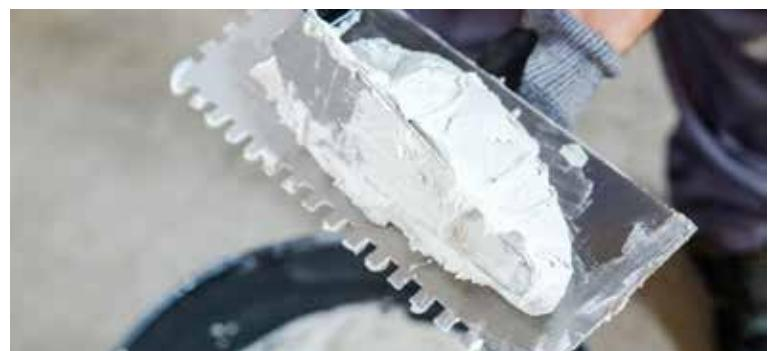
Spread the adhesive cement with a toothed trowel | Extiende el cemento de agarre con una llanta dentada | Étende le ciment à prise rapide à l'aide d'une spatule dentée | Verstreichen Sie den Klebemörtel mit einem Zahnpachtel
