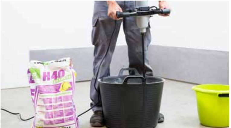
Prepare the adhesive cement | Prepara el cemento de agarre | Préparer le ciment à prise rapide
