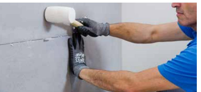
Use the flexible rubber mallet | Utiliza una maza de goma flexible | Utiliser un maillet en caoutchouc souple | Verwenden Sie einen biegsamen Gummihammer
