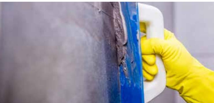
Use a grout trowel to affix the material | Utiliza una llana de rejunto para fijar el material | Utiliser une spatule pour joints pour fixer le matériau | Verwenden Sie eine Fugenkelle zum Andrücken des Materials
