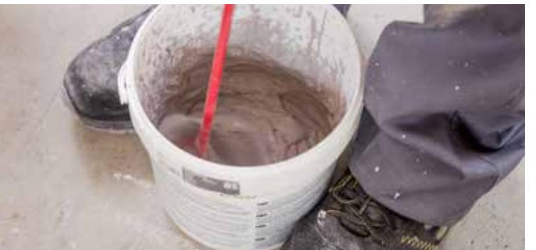
Prepare the grout | Prepara el material de rejunto | Préparer le matériau de jointoient | Rühren Sie das Fugenmaterial an
