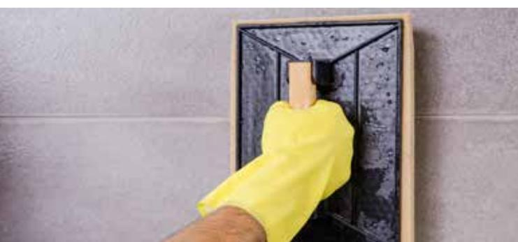
Remove any leftover grout and other dirt | Elimina los residuos de junta y demás suciedad | Éliminer les résidus de jointoient et autres saletés | Entfernen Sie Fugenmaterialreste und andere Verunreinigungen
